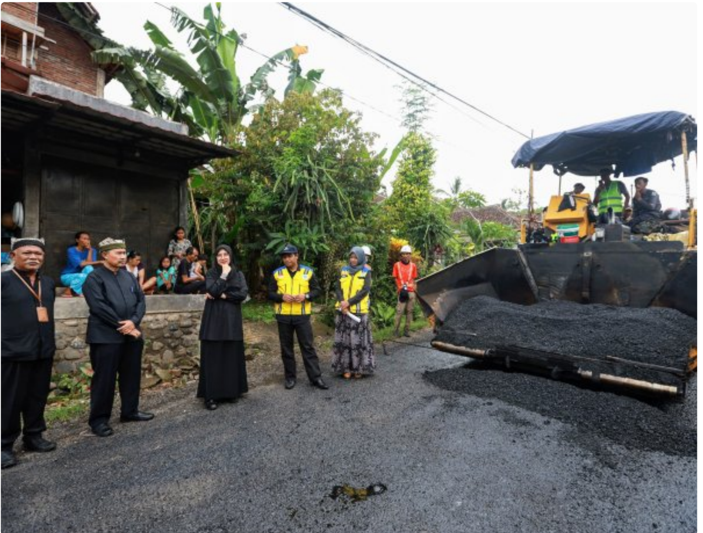
Bupati Banyuwangi Ipuk Fiestiandani meninjau progres pengerjaan pembangunan ruas jalan Rogojampi-Songgon
